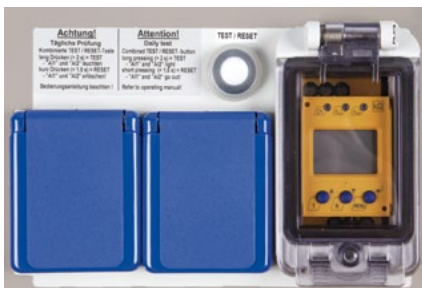
Abb. 11 IMD mit Prüftaste und zugeordneten Steckdosen
